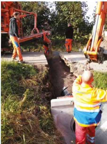
Travaux rue Jonchère
