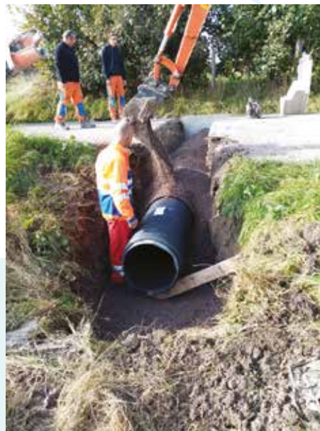
Travaux rue Jonchère
