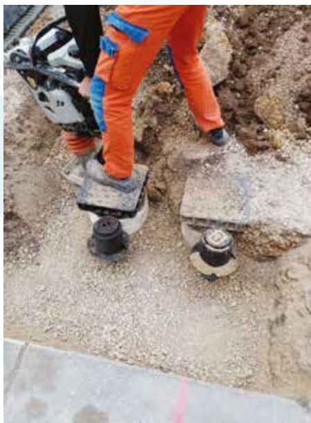
Travaux rue Champs Pussin
