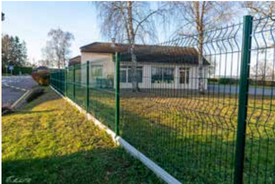
Remplacement clôture du Groupe scolaire
