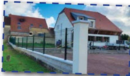
Pose du grillage rigide Poste
